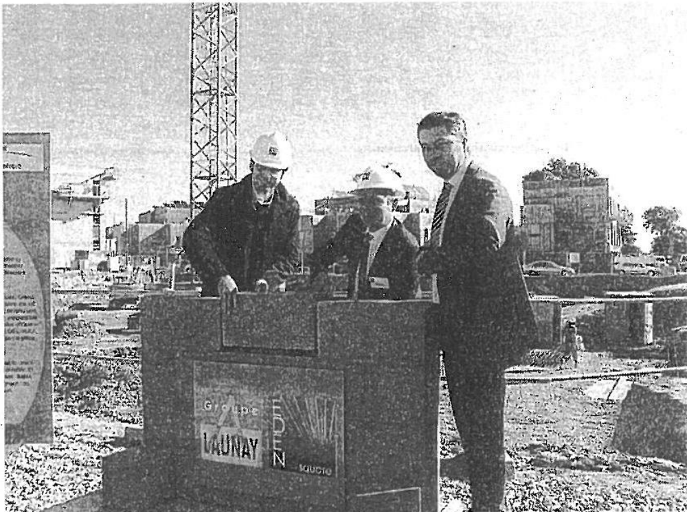
La pose de la première pierre d'Eden Square s'est déroulée mardi.
